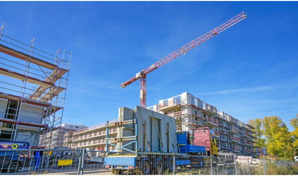
Auf aktuellen Baustellen dreht sich bei der Vonovia noch der Kran. Doch Neubaugenprojekte enden momentan beim Baurecht. SCHOENING / PICTURE ALLIANCE
